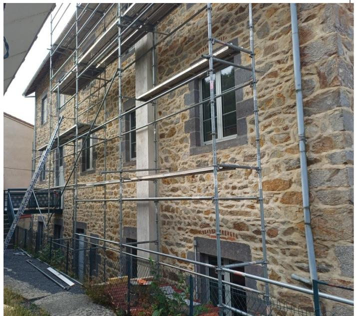
Un très grand échafaudage a pris place à l'arrière de l'école. C'était la seule solution, car l'arrière du bâtiment n'est accessible à aucun engin et la hauteur ne permettait pas d'intervenir à l'échelle. Il était devenu urgent de remplacer les chéneaux, qui par leurs fuites, occasionnaient des infiltrations d'eau sur les murs des classes.
