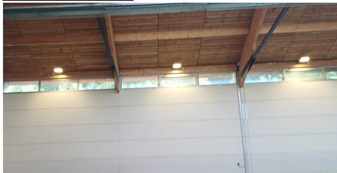
Dans notre volonté de remplacer les éclairages par des nouveaux à leds, moins consommateurs d'énergie, l'entreprise Courteix a procédé au changement des vieux projecteurs halogènes intérieurs du gymnase, ce qui devrait entraîner une économie d'énergie d'environ 60 %. Le montant des travaux s'élève à 7 477 € HT.
