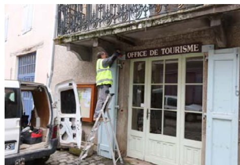
Pose d'une antenne Wifi, une seconde sera posée sur le bâtiment de la mairie.
